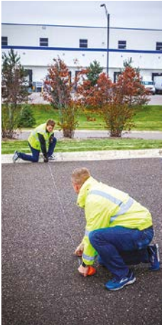
Méthode traditionnelle: Nécessite une corde, une craie et 2 personnes
